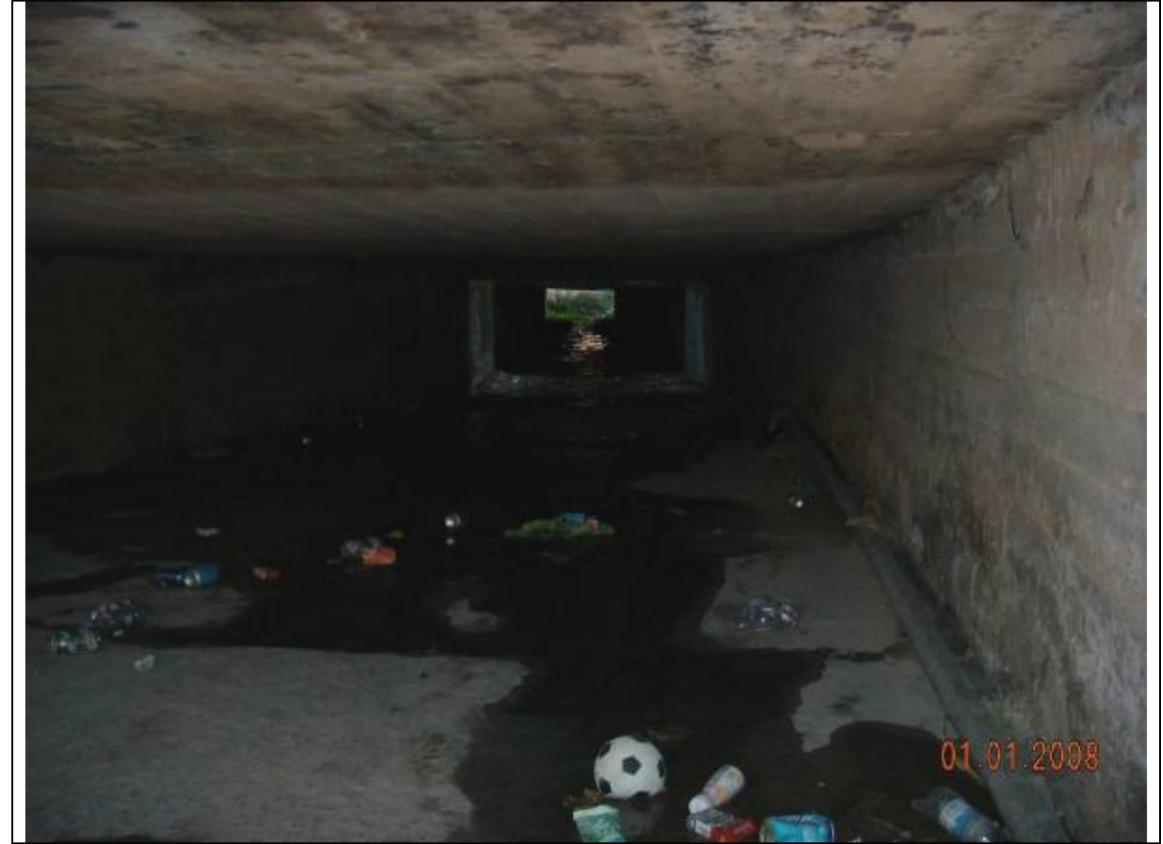
Fotografía 3 – Nos hemos introducido dentro de la obra y hemos tomado esta fotografía de su tránsito por debajo del vial. La altura libre es de 1.20 m y el ancho final, tras el estrechamiento de 5,0 m.
