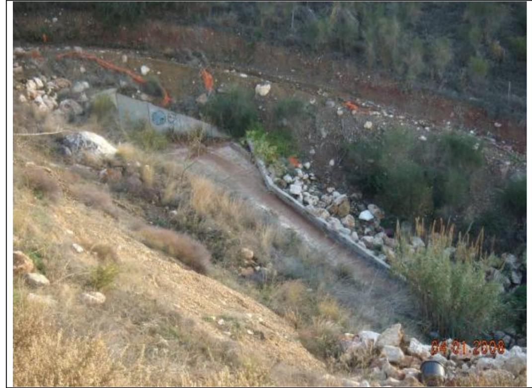
Fotografía 11 – Un pequeño espacio no embovedado existente entre dos obras de drenaje longitudinal. A nuestra izquierda está la boquilla que veíamos en el centro de la fotografía anterior.
