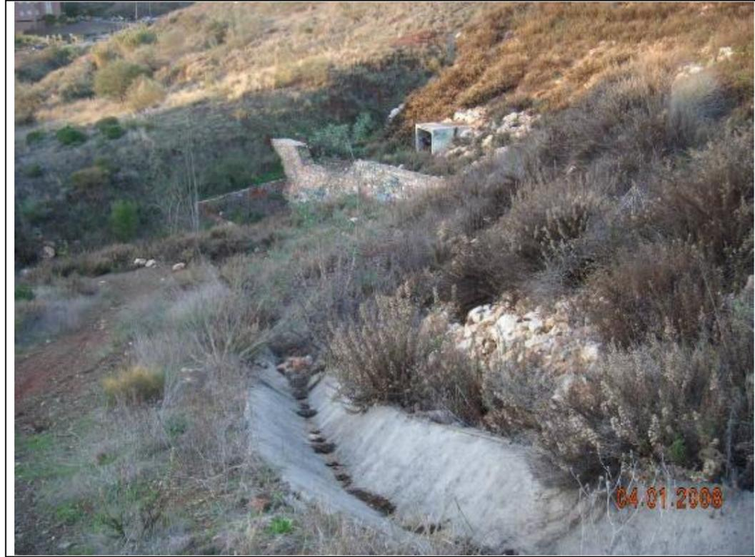
Fotografía 9 – Esta cuneta revestida evacua hacia el cauce principal el área vertiente de la vaguada que mostramos en la fotografía siguiente. En el centro de la imagen vemos la salida del cajón que veíamos con más detalle en la fotografía anterior.
