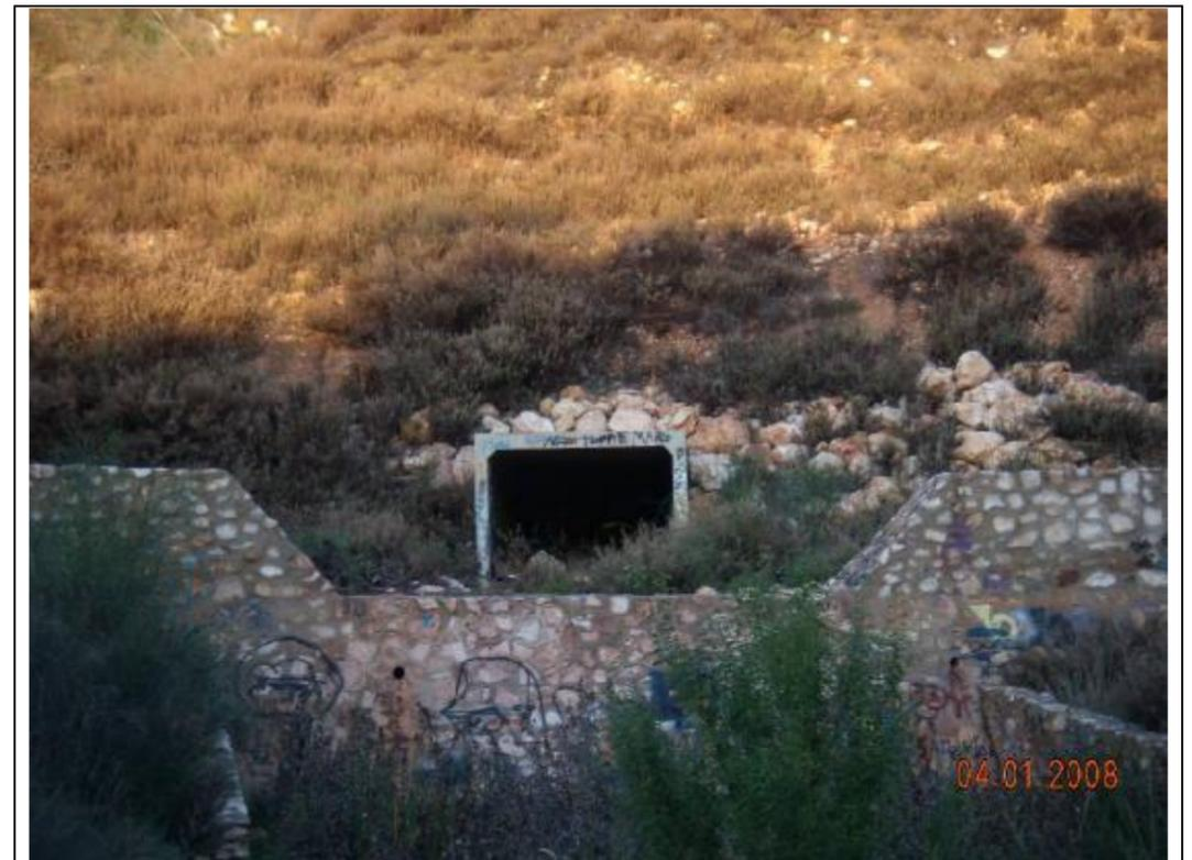
Fotografía 8 – Al pie del terraplén situado bajo los edificios que vemos al fondo de la fotografía anterior nos encontramos este marco, de 3,00 x 2,50 m, que tiene un giro importante de su alineación justo antes de su salida.
