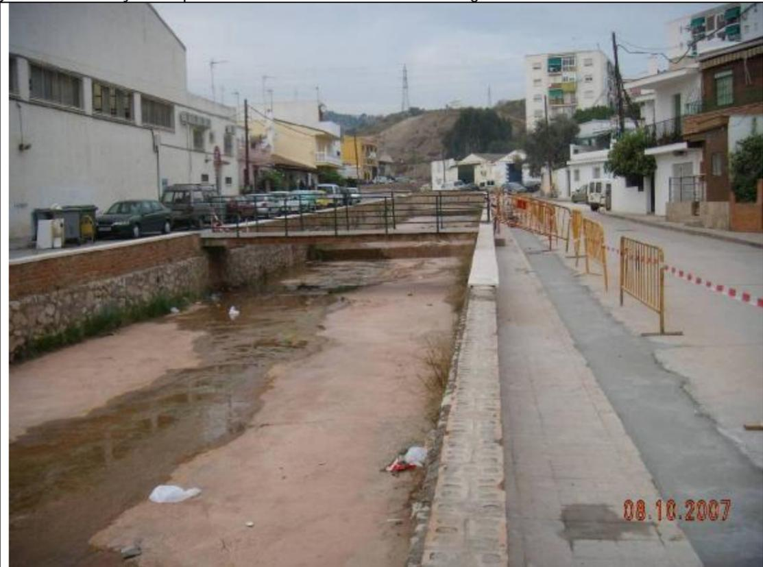
Fotografía 2 – Hacia aguas arriba se mantiene un buen tramo con el mismo encauzamiento. La anchura alcanza 8,0 m y la altura hasta la albardilla es de 1,40 m.
