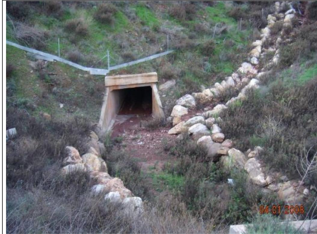
Fotografía 13 – Al norte de la A\_7 existen esta embocadura de un cajón con la misma sección, 3,00 x 2,50 m, que tiene el de la fotografía nº 8. A partir de este punto el cauce , y su área vertiente, ya se implantan al norte de la Autovía y son perfectamente identificables con la cartografía digital.
