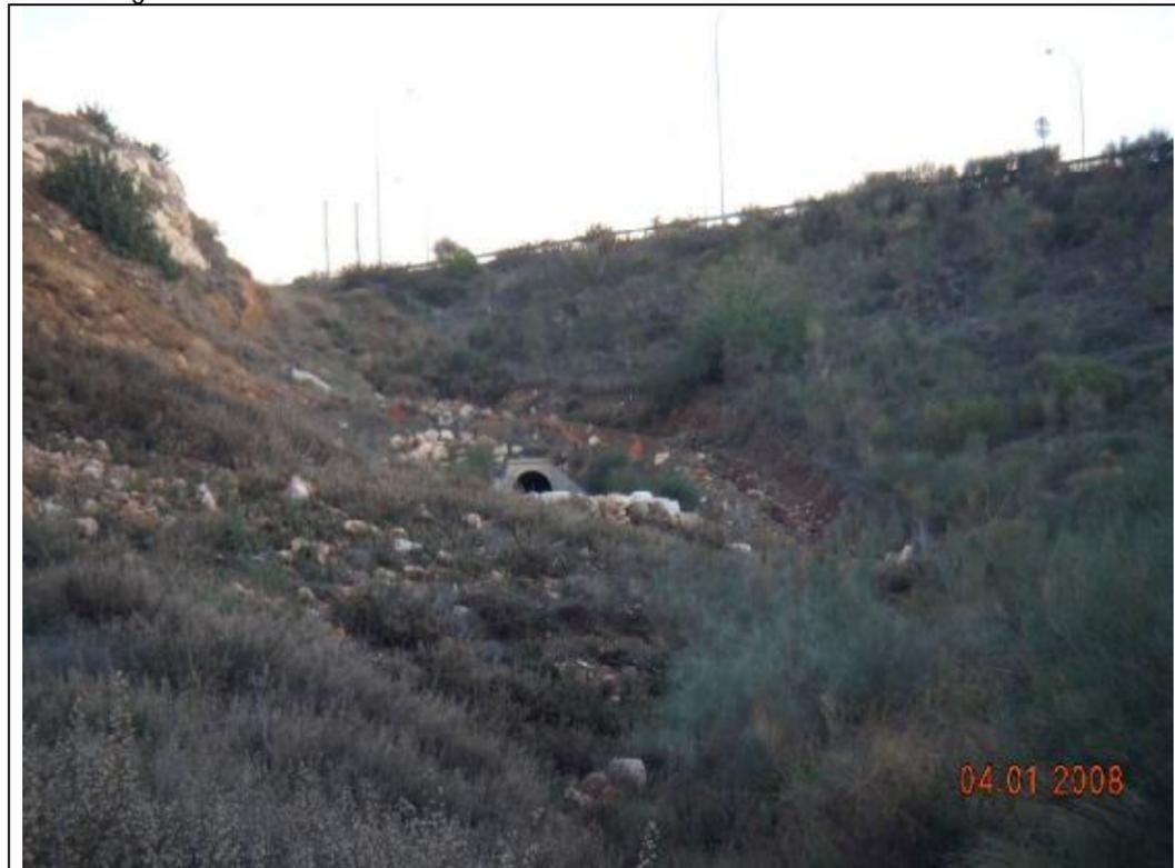
Fotografía 10 – Girando la cámara 180° vemos el final de la obra de drenaje longitudinal que atraviesa el ramal de la A-7 que une esta vía con Laraña. Tiene menos sección que el cajón anterior.
