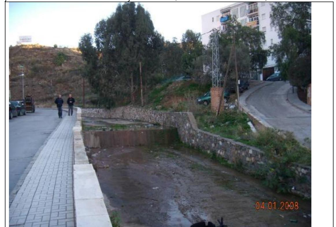
Fotografía 4 – La fuerte pendiente del tramo encauzado del arroyo se pone de manifiesto con la existencia de resaltes como el que muestra la fotografía.
